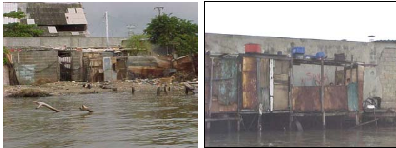
Foto 3.- Soluciones habitacionales de los pobladores que se asientan en las márgenes del río, hacia el final de la desembocadura.
